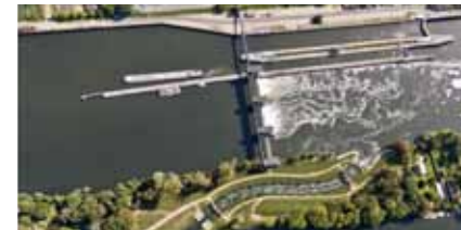
La Seine, Barrage d'Andrésy, France Réalisation d'une passe à poissons, aménagement végétal des berges, 2007–2010 Maître d'ouvrage: VNF, Service Navigation de la Seine, Paris
