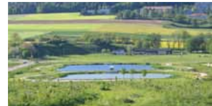
Autoroute A16 sections 1 à 8, Jura Compensations écologiques, aménagement végétal des talus et des étangs de sécurité 1991–en cours Maître d'ouvrage: République et Canton du Jura, Service des ponts et chaussées
