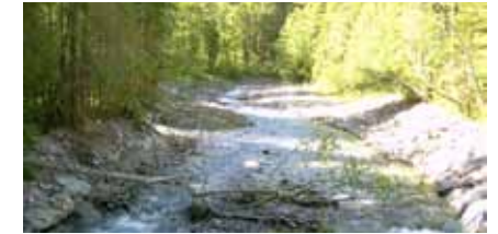
Entreprise de correction fluviale de la Grande Eau, Les Diablerets, Vaud Travaux de sécurisation du village des Diablerets et renaturation de la Grande Eau, 1999–2008 Maître d'ouvrage: Canton de Vaud, SESA
